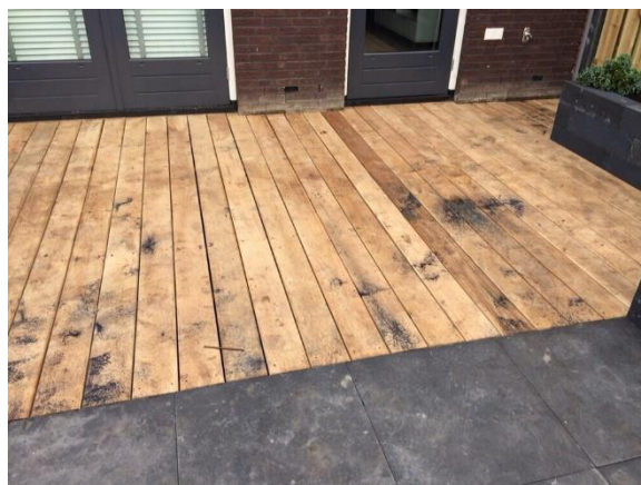
Figuur 1 Zwarte vlekken door ijzeroxidereactie
