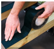
Bescherm de onderbalk met Bitudeck (Art.2336) Zie Cobrafastener catalogus.
