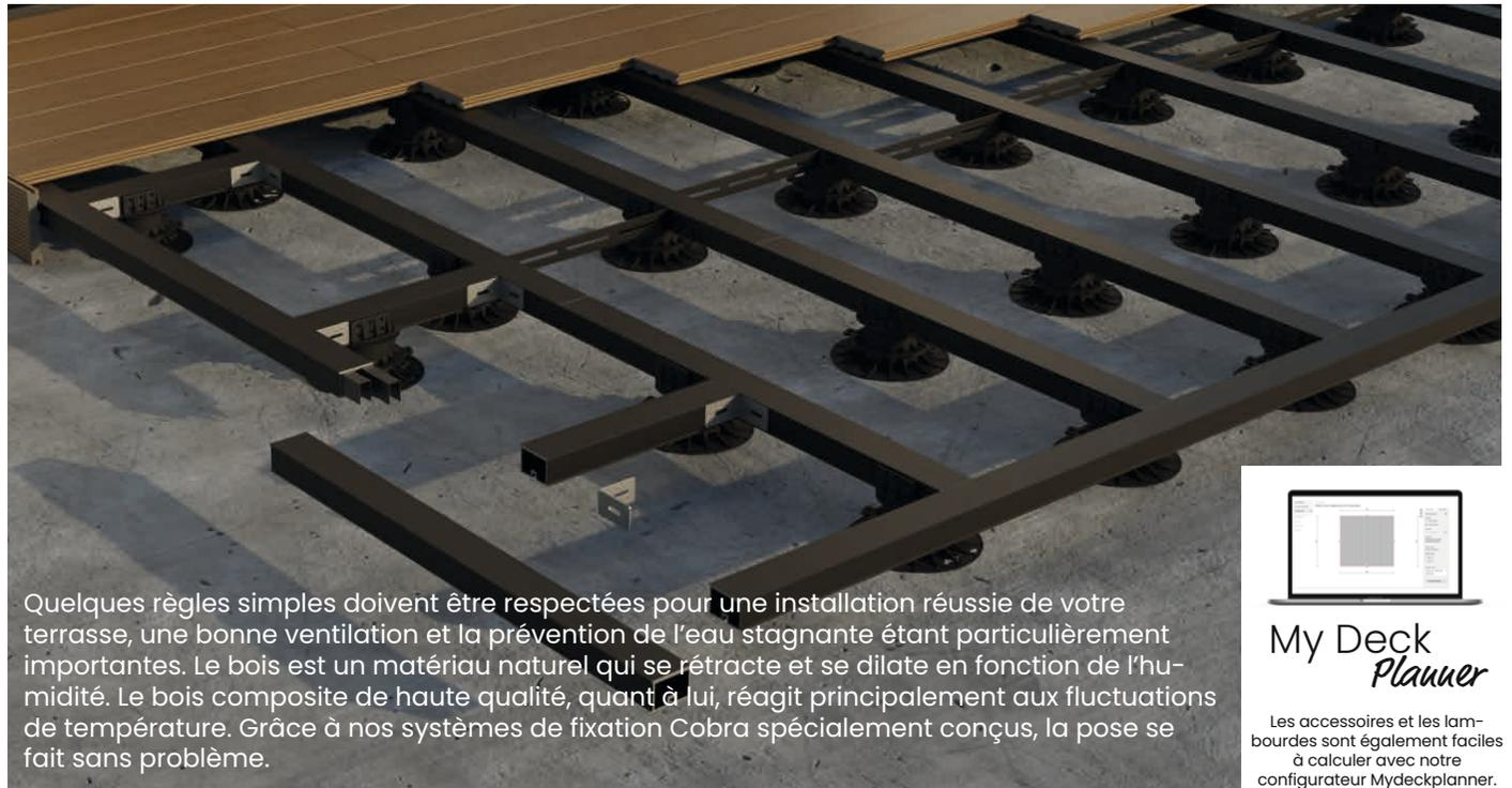
Quelques règles simples doivent être respectées pour une installation réussie de votre terrasse, une bonne ventilation et la prévention de l'eau stagnante étant particulièrement importantes. Le bois est un matériau naturel qui se rétracte et se dilate en fonction de l'humidité. Le bois composite de haute qualité, quant à lui, réagit principalement aux fluctuations de température. Grâce à nos systèmes de fixation Cobra spécialement conçus, la pose se fait sans problème.
